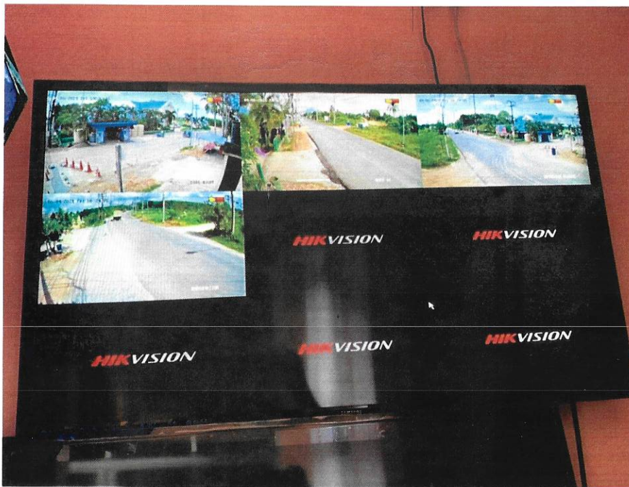
รูปที่ ๓ ศูนย์ควบคุมภายในสำนักงาน อบต.แก่ง
